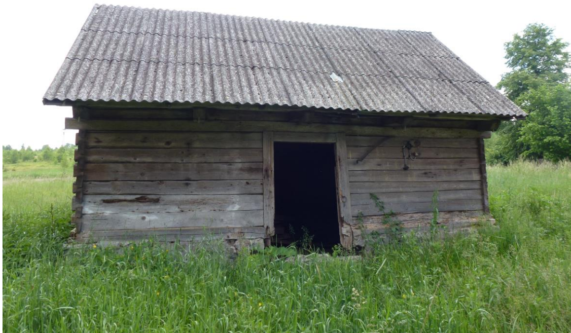
Rys. 9. Budynek pokryty azbestem falistym (Źródło: Fotografia własna)
