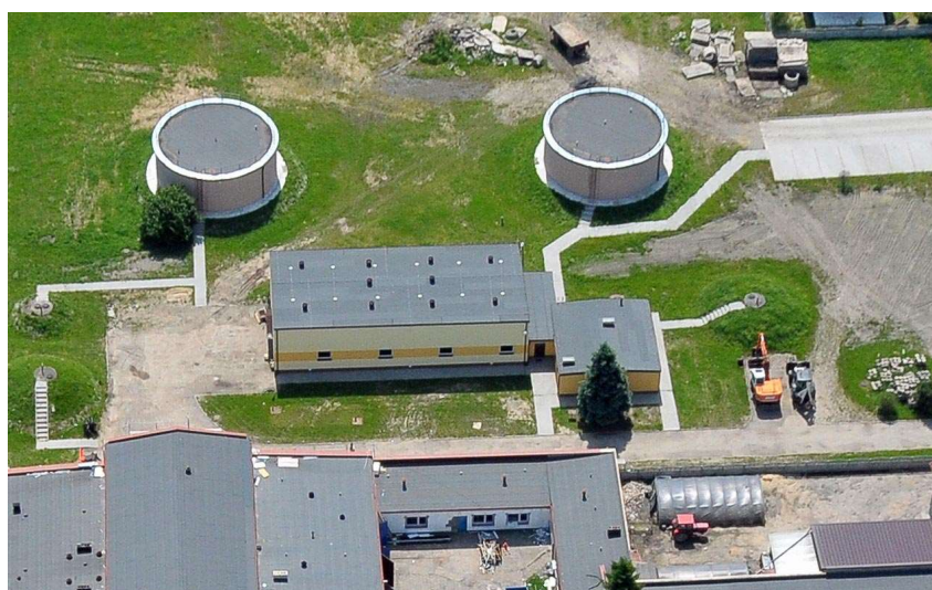
ZGKiM w Piątku – stacja uzdatniania wody w Piątku, ul. Stodolniana
