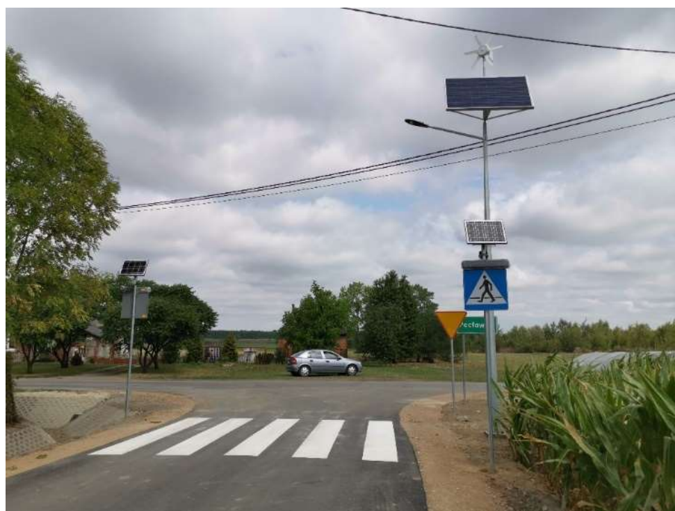
Pęcławice - przebudowana/zmodernizowana droga gminna
