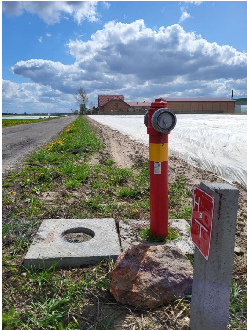
Foto: Realizacja budowy wodociągu w Łęce i Bielicach
