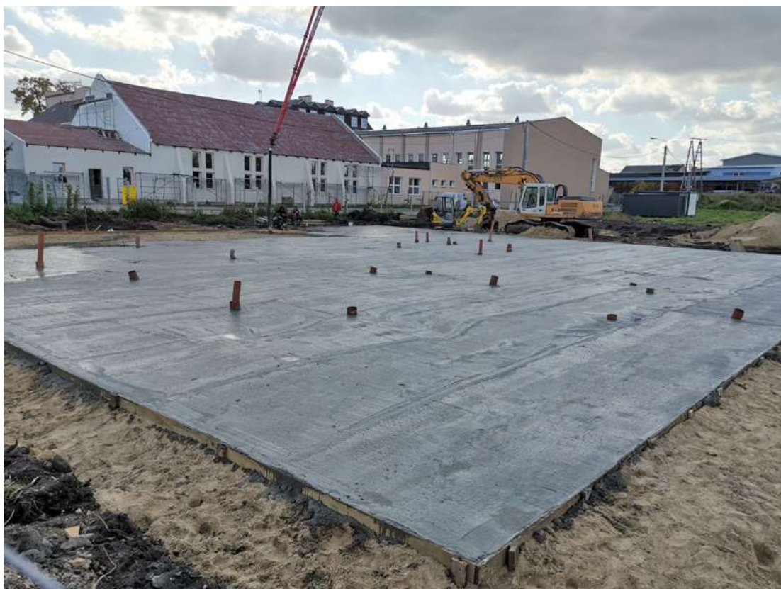
Foto: Początek budowy pasywnego budynku przedszkola w Piątku
