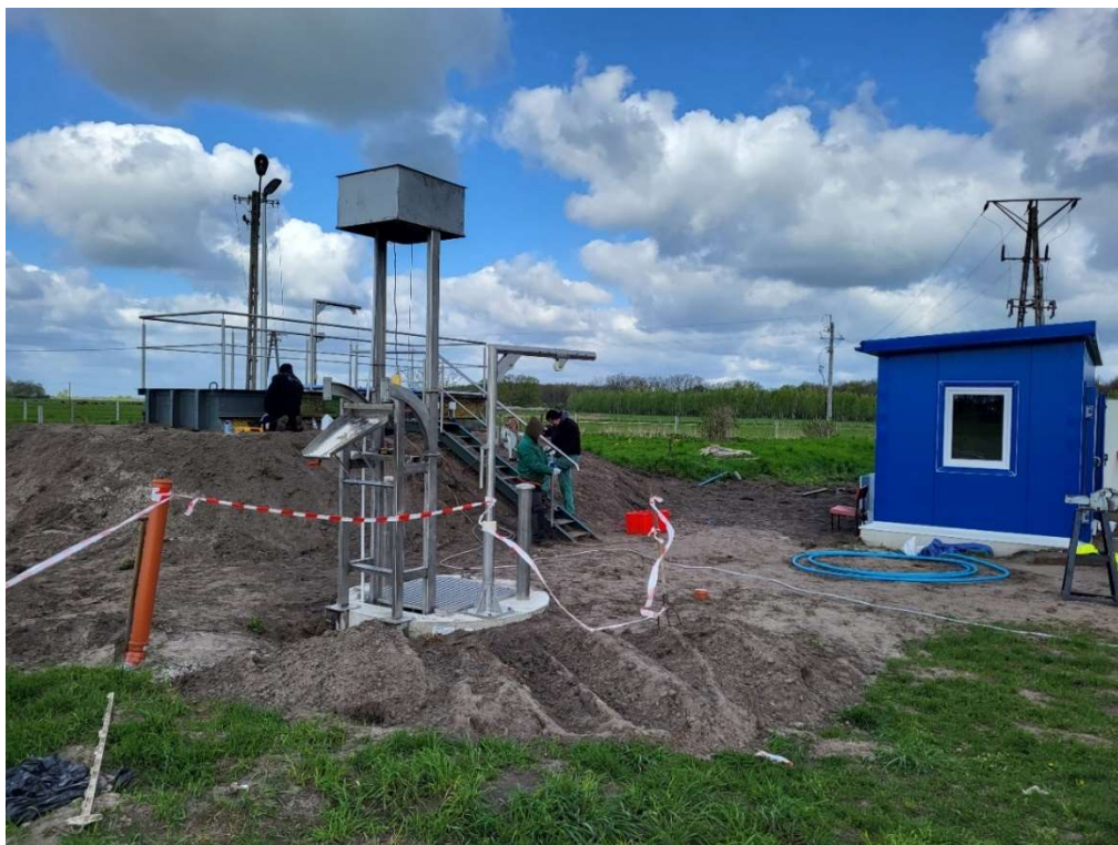
Foto: Remont oczyszczalni biologicznej w Goślubiu
